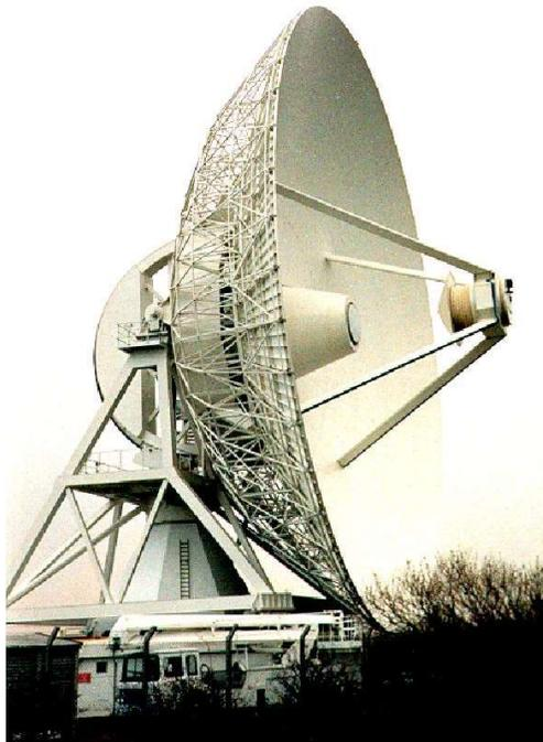
Quanto à colocação da “feed” (waveguide), esta ou é colocada no foco principal ou num foco “**tipo**” **Cassegrain** ( $f/número < 1$ ). Menos comum, mas com a sua utilização a aumentar rapidamente, é a utilização de um foco Cassegrain genuíno.
