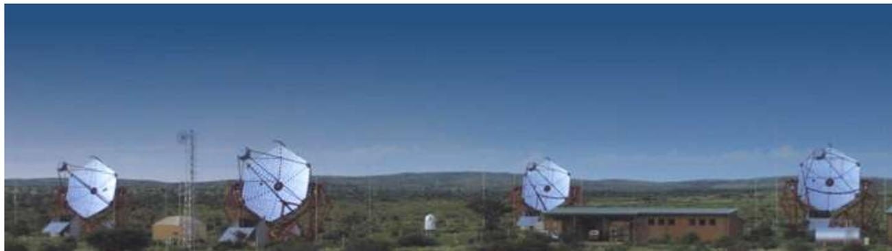
A rede de “telescópios” Čerenkov HESS (High Energy Stereoscopic System) na Namíbia, com quatro  $D=19\text{m}$  (na fase 2 será colocado um de  $28\text{m}$ ). Detectam raios  $\gamma$  nos  $\sim 100\text{ GeV}$ .
