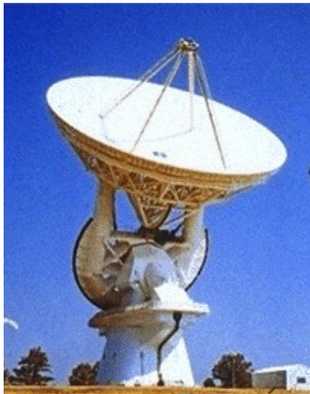
*Uma ferradura também é utilizada pelo rádio telescópio de Green Bank (25m – VLBA).*
