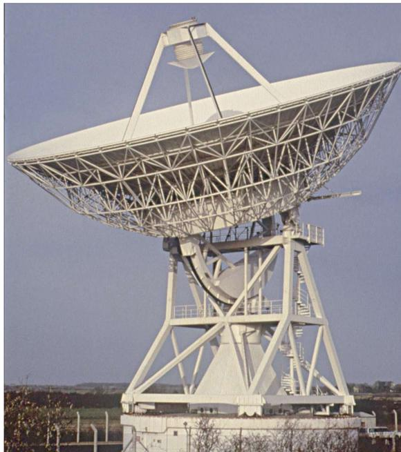
*A montagem altazimutal de rádio telescópios consiste nuns **carris circulares** para o movimento em azimute e num **eixo de altura** para o movimento elevatório.*
