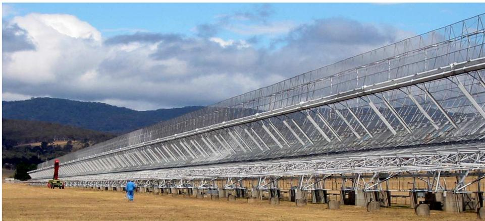
**Figura 1.22** – Em cima: rede de dipolos BSA (Puschino, Rússia), com  $70000\text{m}^2$  de área efetiva. Em baixo, uma rede de dipolos em forma parabólica (MOST, Austrália);  $18000\text{m}^2$ .
